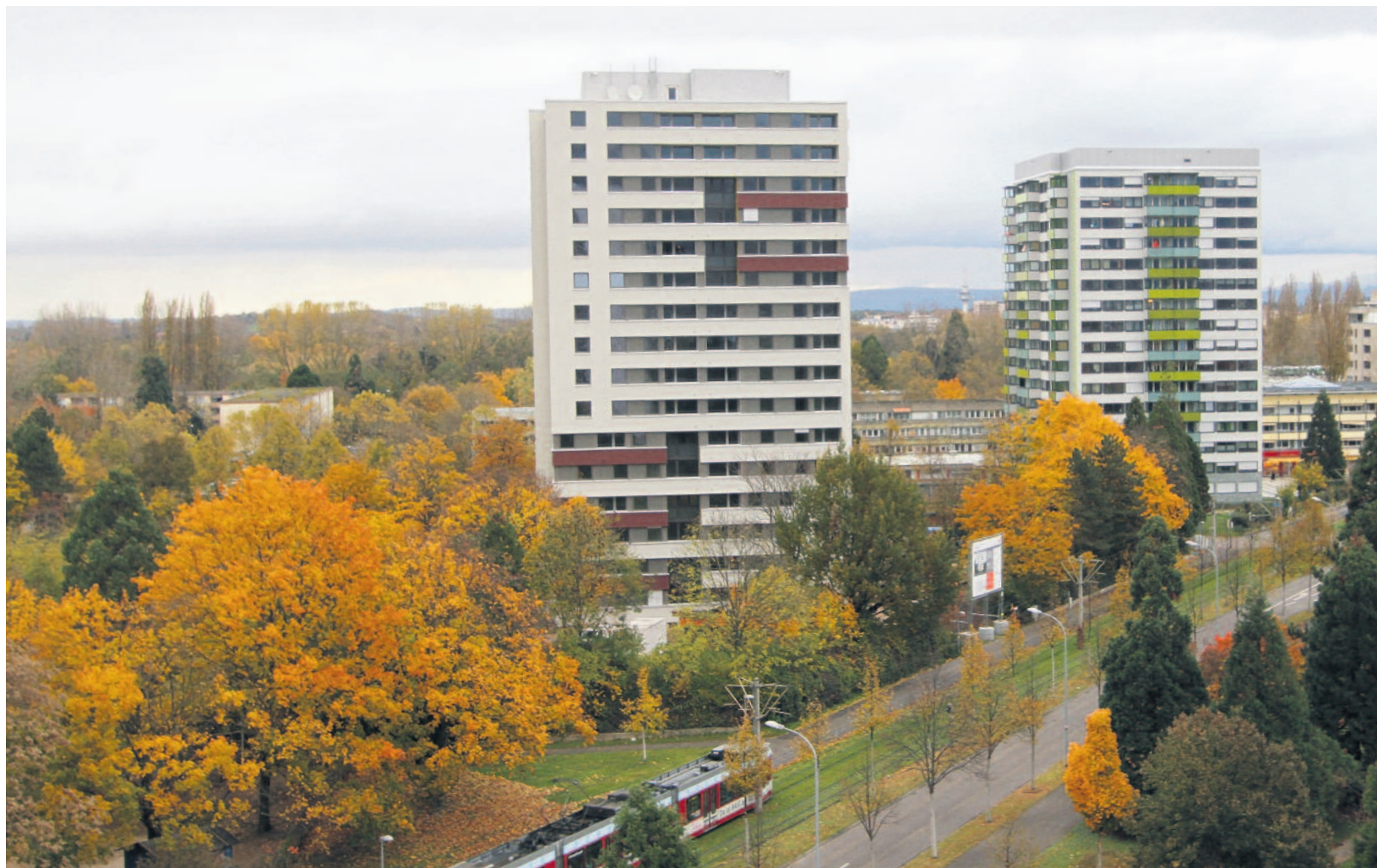
Nach der Bugginger Straße 50 ist nun auch die Sanierung und Modernisierung des Hochhauses Binzengrün 9 auf Passivhausstandard abgeschlossen.
